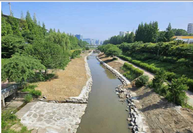
공사 중(상암교 ~ 성미다리 구간)
