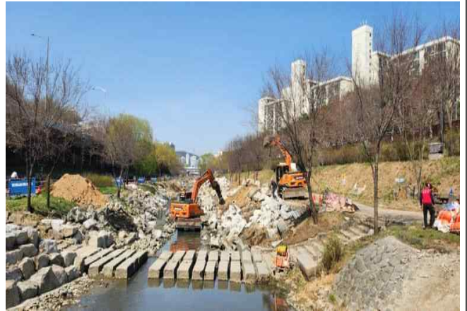
공사 중(성산천 합류부)
