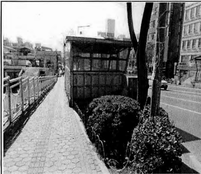
마포구청역(가로변 띠녹지내 설치)
