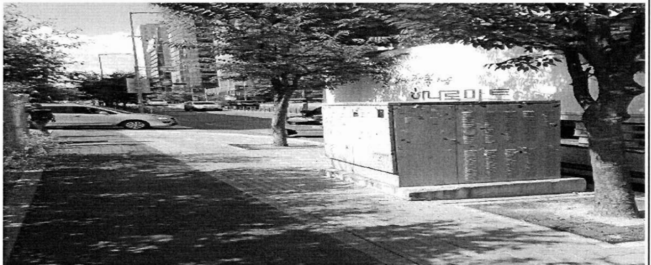
상암동 하나로마트 1대 : 6월30일까지 철거 추진(선로공사 완료)
