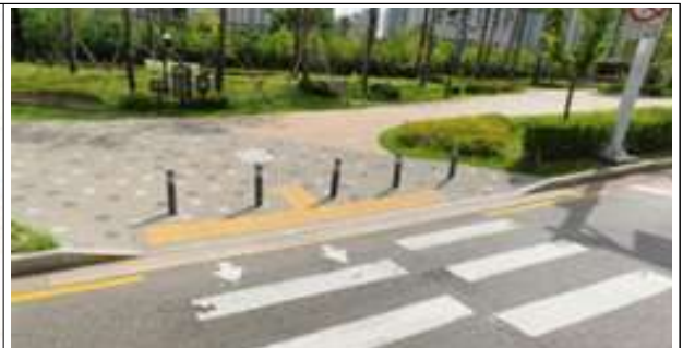
횡단보도 전체 턱 낮춤(정비 후)
