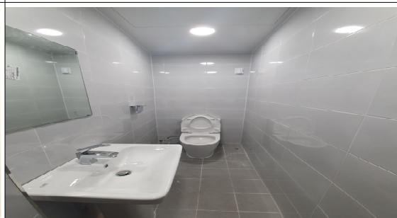
공사 후 (여자화장실 설치)
