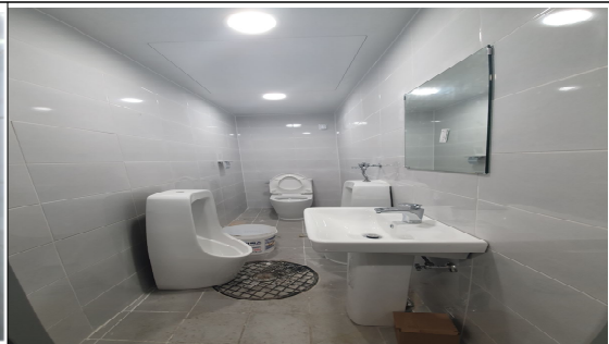
공사 후 (남자 화장실)
