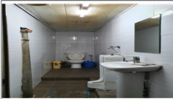
공사 전 (남녀 공용 화장실)
